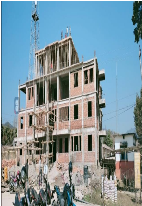
आयोजना निर्माण चरणको अवस्था
