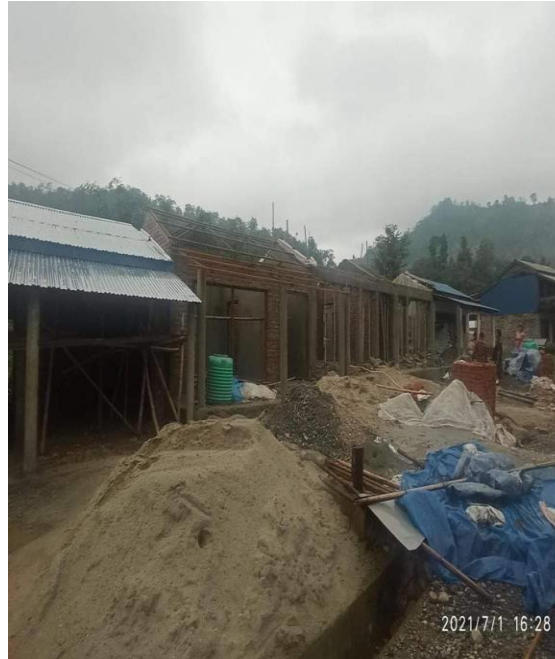
आयोजना निर्माण चरणको अवस्था
